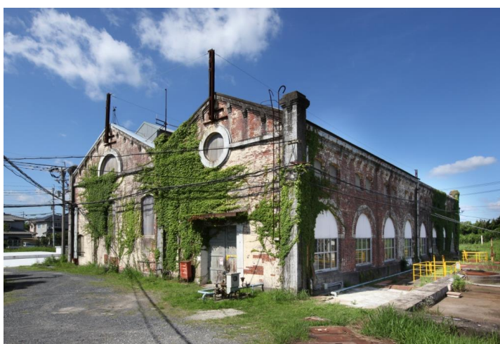
遠賀川水源地ポンプ室 ※非公開施設 （新日鐵住金（株）八幡製鐵所提供）
